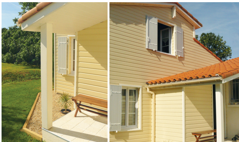
UPM Kaukaan terveeksalaatuista sahatavaraa koossa 50x150 jatkojalostetaan Ranskalaisen omakotitalojen ulkoverhouslaudoiksi.
